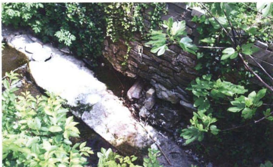
Foto 10 – Argine del torrente Chiappeto con evidenti segni di smottamento
