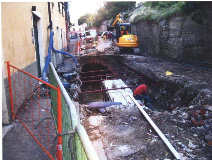
Foto 12 – Il cratere lungo via Pontetti creato dalla pressione delle acque del torrente Chiappeto, con evidenziazione del canale di scorrimento del rio interrato (alluvione 4 novembre 2011)
